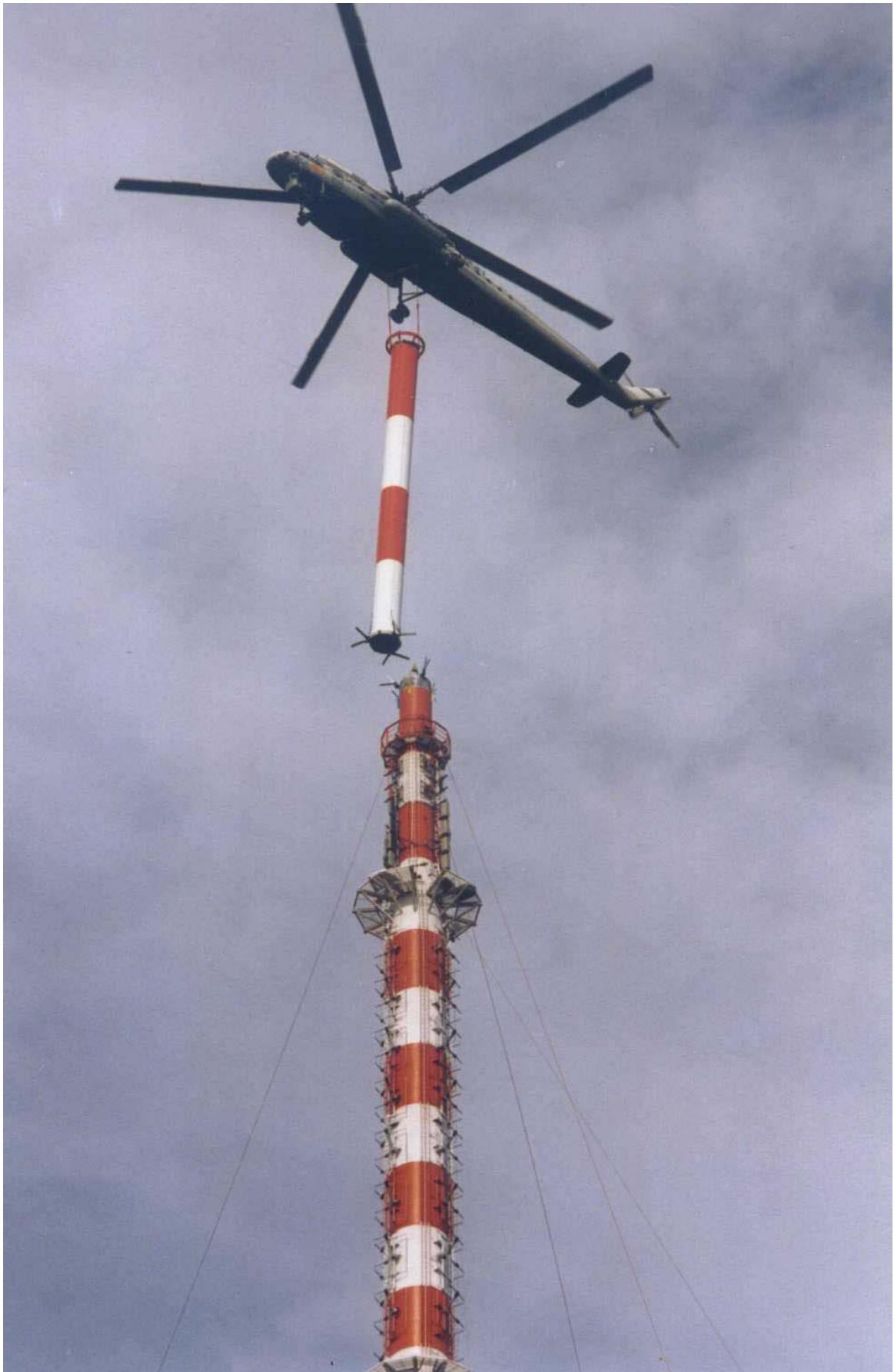
Bild 16: Hubschrauber montage
