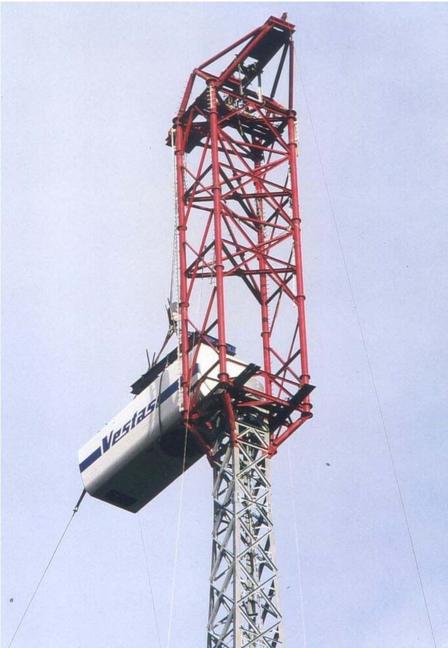
Bild 20: Einfahren des Maschinenhauses in 113 m Höhe
